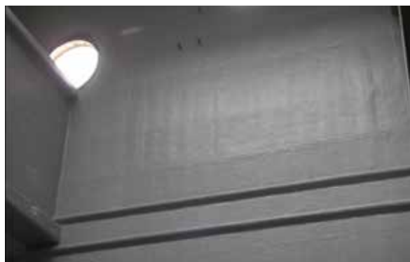
已完成涂装的Ceilcote 242 Flakeline
