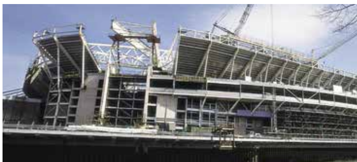
Viele städtische Bereiche sind in die Korrosivitätskategorie C3 nach ISO 12944 einzustufen.
