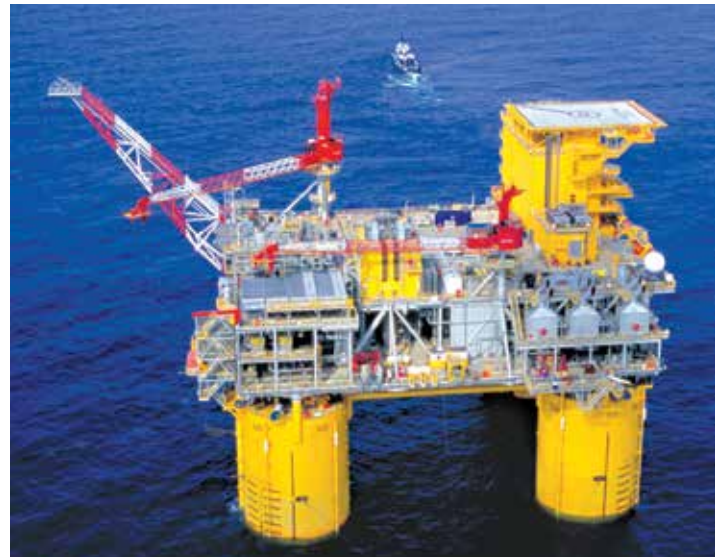
In Küsten-/Meeresbereichen (Korrosivitätskategorie C5M) herrschen die schwierigsten Bedingungen, und es sind Systeme mit einer längeren Schutzdauer erforderlich.
