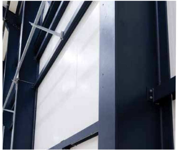
Teräsrakenne, Rotterdamin lentokenttä, Alankomaat
