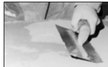
Trowel Apply Topcoat
