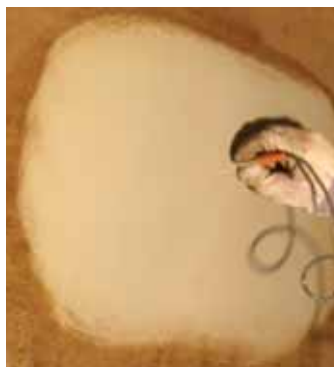
Excelente desempenho a longo prazo em tanques de lastro após 15 anos em serviço. O Intershield® 300 não apresenta desgaste nas bordas
