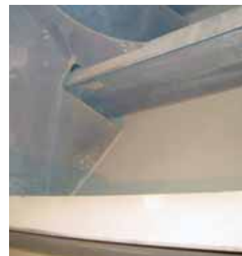
Excelente desempenho a longo prazo em tanques de lastro após 15 anos em serviço. O Intershield® 300 não apresenta desgaste nas bordas
