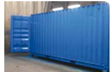
Auftrag der Deckbeschichtung Interthane 990 am zweiten Tag abgeschlossen
