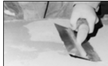
Trowel Apply Topcoat
