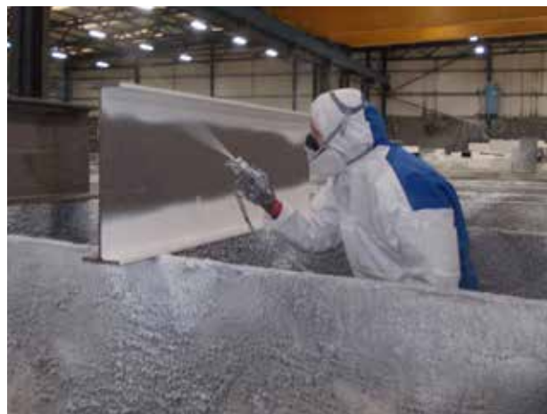
Interchar 2090 sendo aplicado a uma seção em I
