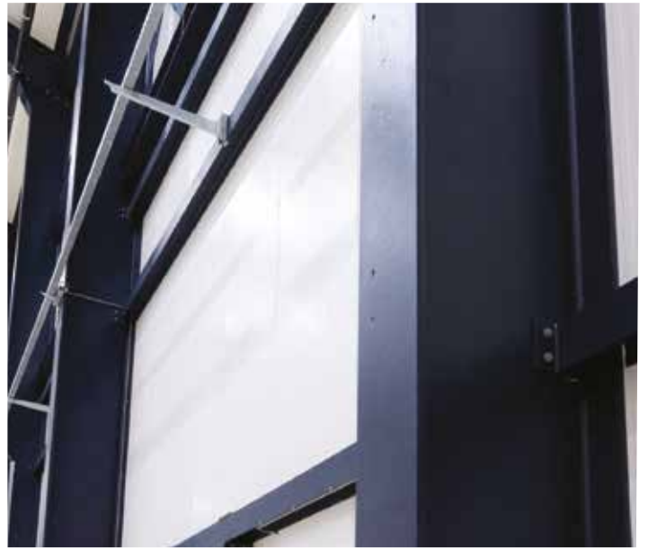
Detail van staal werk, Rotterdam Airport, Nederland
