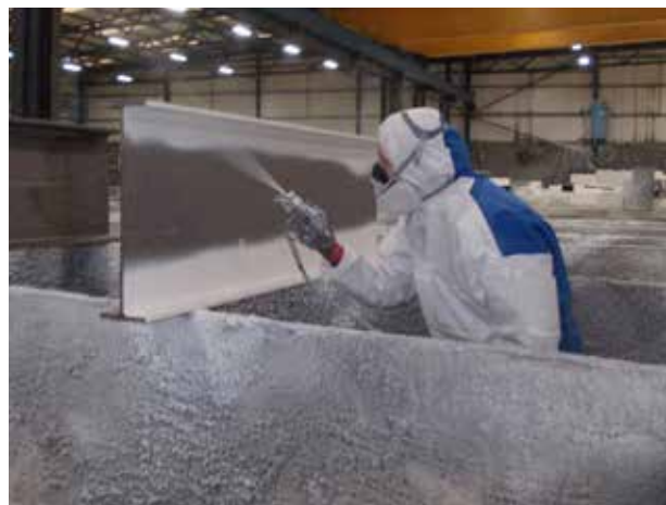
Нанесение Interchar 2090 на балку
