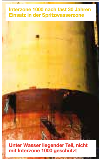
Interzone 1000, nachgewiesene Leistungsfähigkeit auf Bohrplattform „Hutton“
