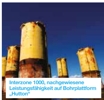
Interzone 1000 nach fast 30 Jahren Einsatz in der Spritzwasserzone
