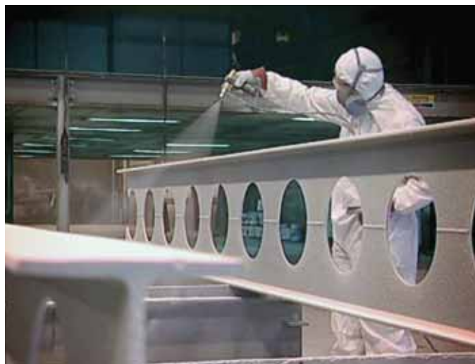
Påføring på celdebjælker
