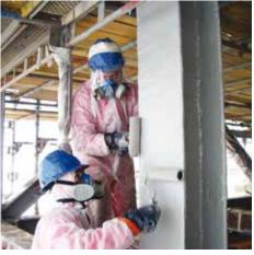
Vorgegossene Platten von Chartek 7 ermöglichen die rasche Installation des passiven Brandschutzes bei Anlagen und Bauten, die regelmäßig überprüft werden müssen.
