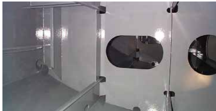
Intershield 300 после нанесения.
