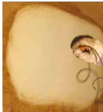
Прекрасное состояние покрытия балластного танка после 15 лет службы. Intershield 300 не разрушается на кромках.
