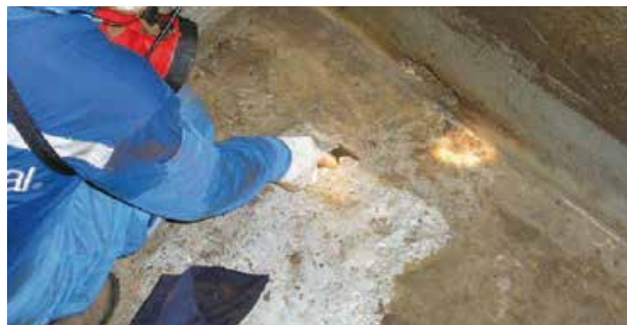
Днище резервуара для сырой нефти с питтинговой коррозией – 6 лет эксплуатации. Общее состояние Intershield 300 прекрасное несмотря на грязь и нефтяные пятна.
