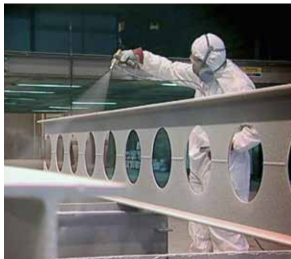
Нанесение на балку с отверстиями
