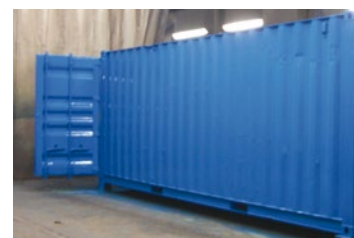
Application de la couche de finition Interthane® 990 accomplie le jour 2
