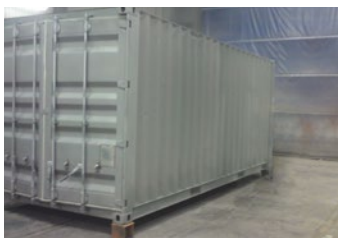
Application de l'Interzinc® 22 à durcissement rapide ainsi que de la couche d'accrochage et de la couche intermédiaire le jour 1
