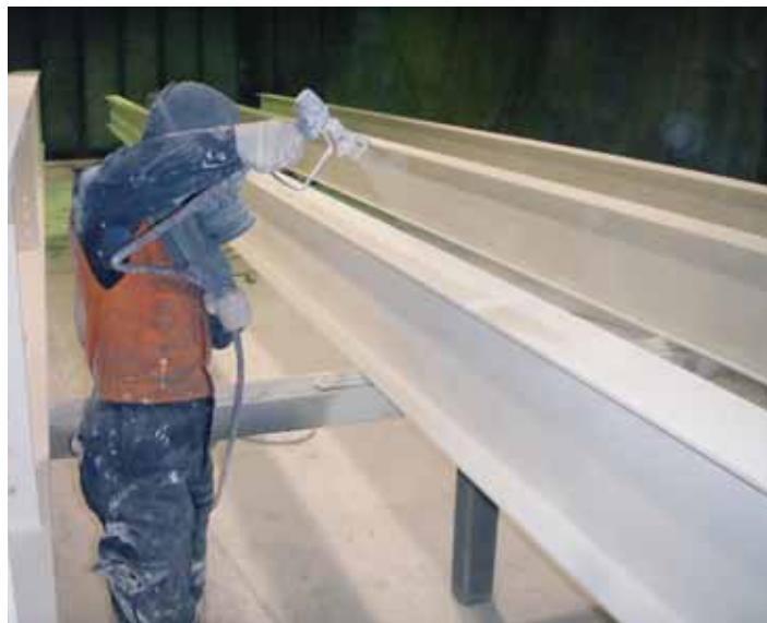
Påføring på massiv I-bjælke
